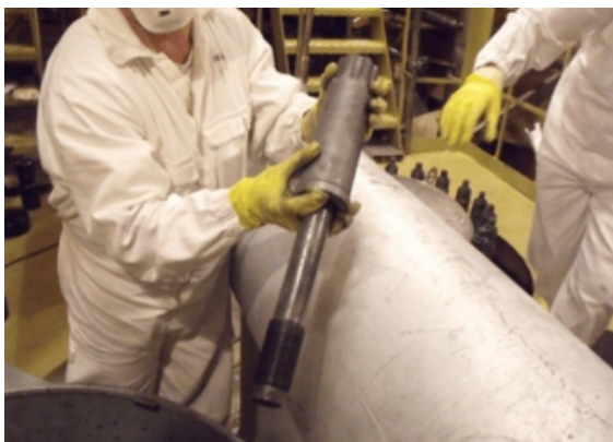
1. ábra. Paksi gőzfejlesztő töcsavara.
