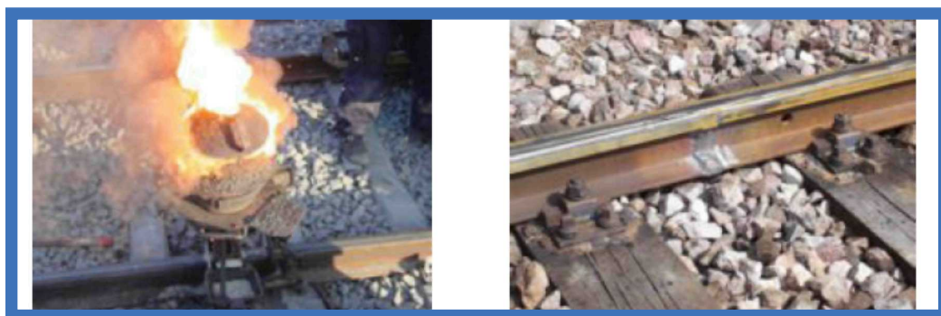
4.42. ábra. Termithegesztés – a termitpor égése és így módon összekötött sínvégek
