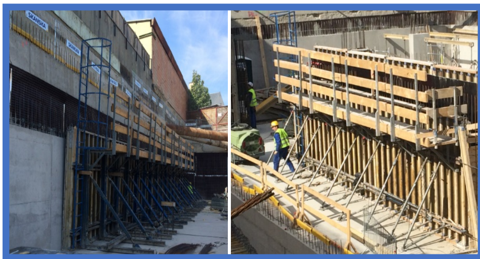
FÜGGŐLEGES MONOLITSZERKEZETEK ZSALUZÁSA
