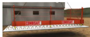
Előregyártott elem beemelése, előre felszerelt védőkorlátokkal
