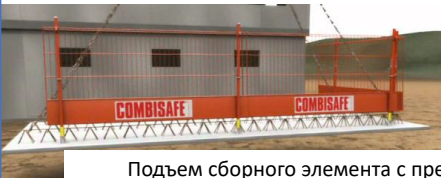
Подъем сборного элемента с предварительно смонтированными перилами
